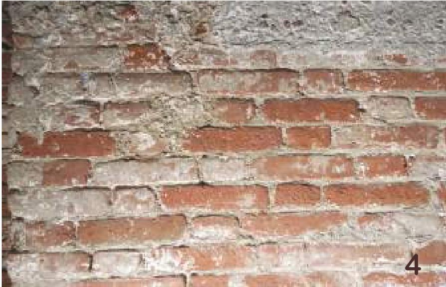
La tecnica muraria dell'edificio è riconducibile a una disposizione degli elementi in orizzontale a 2 teste (foto 4), tessitura gotica, (cit. Koenig G.K., Furiozzi B., *Tecnologia delle costruzioni*, LeMonnier, 2000). Le stilate orizzontali, di giunzione del laterizio, presentano una lisciatura e una pressione della malta a spiovente. La malta di adesione fra i mattoni è costituita da una matrice carbonatica e pietrisco con una granulometria grezza.
