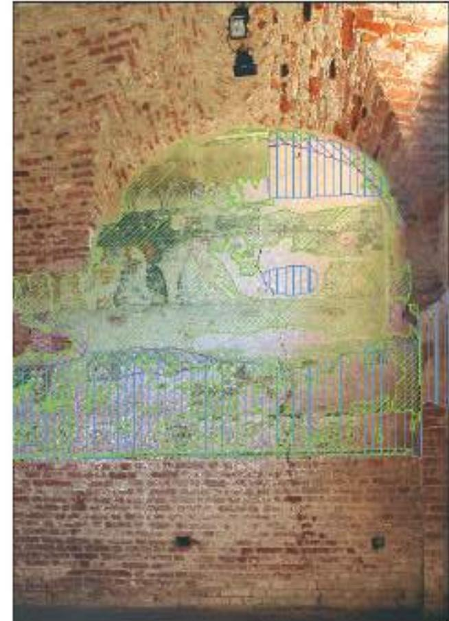
La prima applicazione è stata eseguita con una soluzione di Nanostore® 5g/L di idrossido di calcio in alcool isopropilico, diluito ulteriormente al 10 % in alcool isopropilico. Il ciclo di applicazione è stato ripetuto in 4 stesure, applicate a 24 ore di distanza l'una dall'altra (foto 28).
