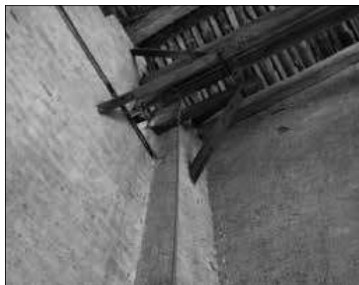
Mensolone in ferro per appoggio trave principale
