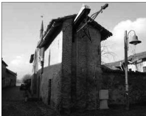
Il fabbricato della pesa di Ranverso
